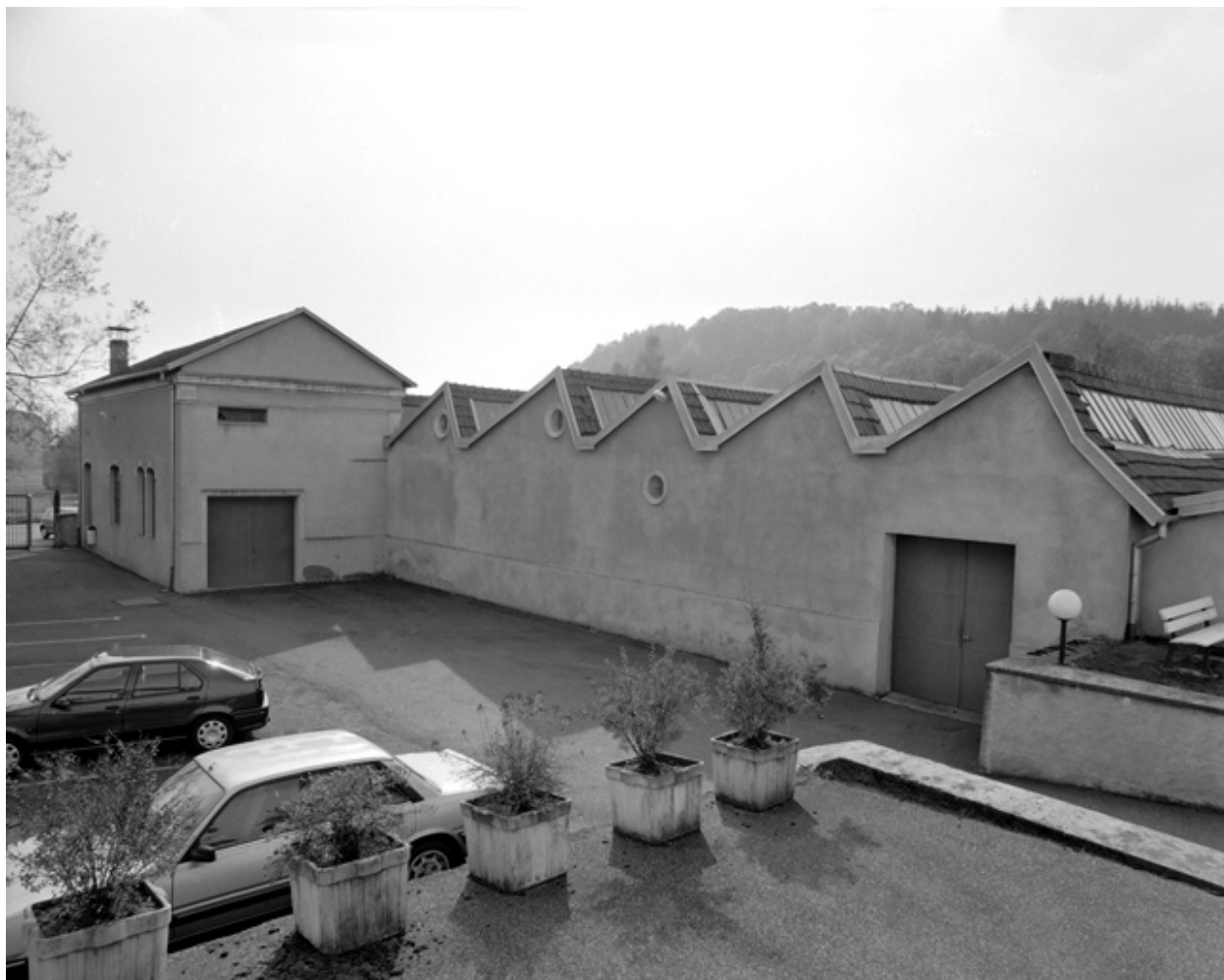
Atelier de fabrication (?) depuis les bureaux.
