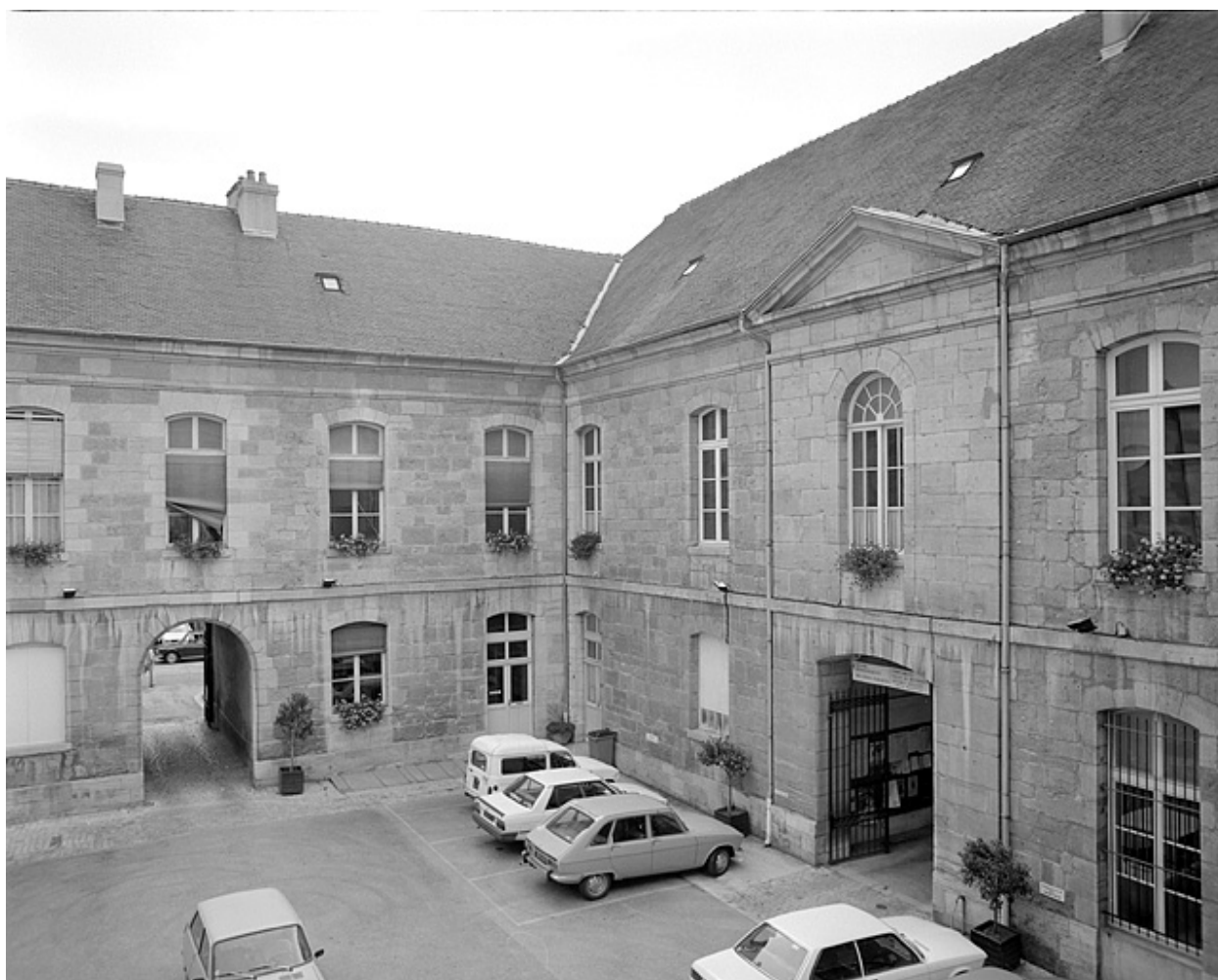
Cour intérieure : côtés est et sud.
