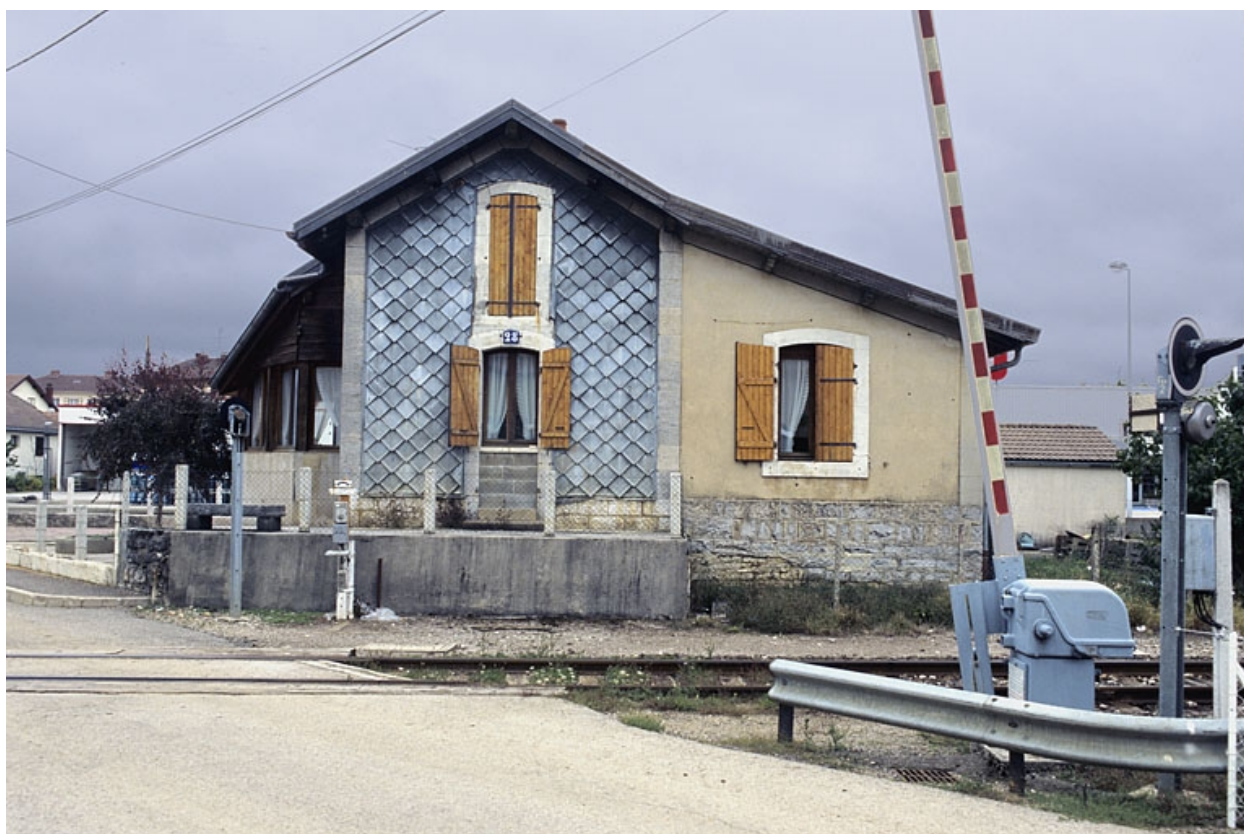
Façade sud (côté voie).
