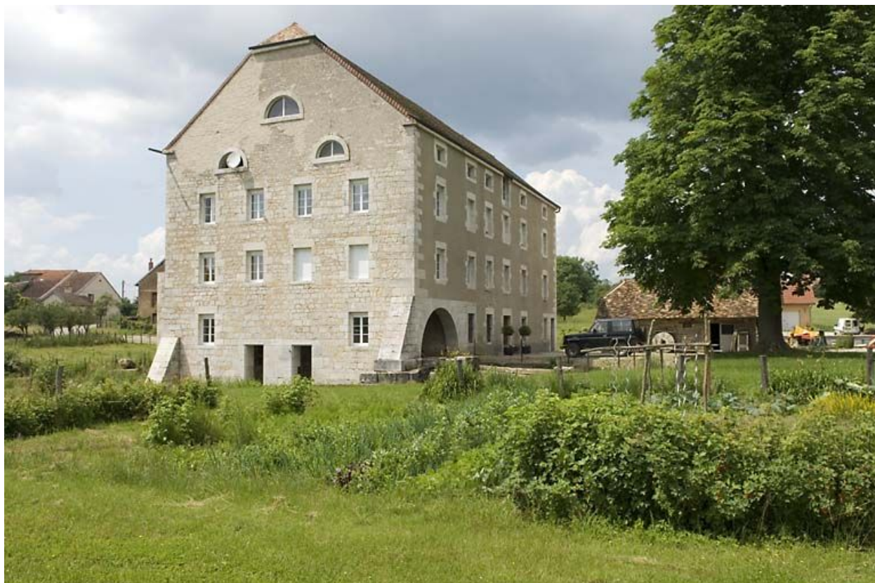
Vue rapprochée depuis le sud-est.
