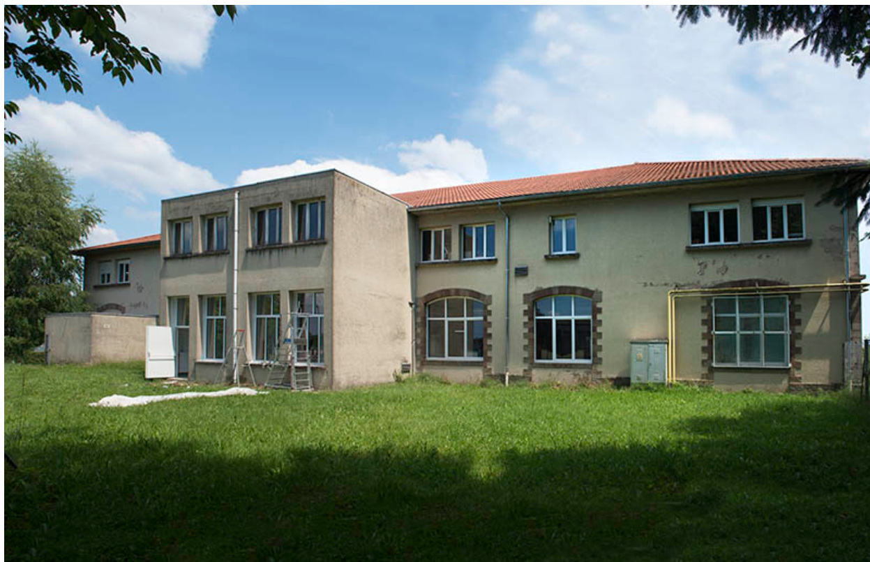
Façade ouest de l'externat atelier.
