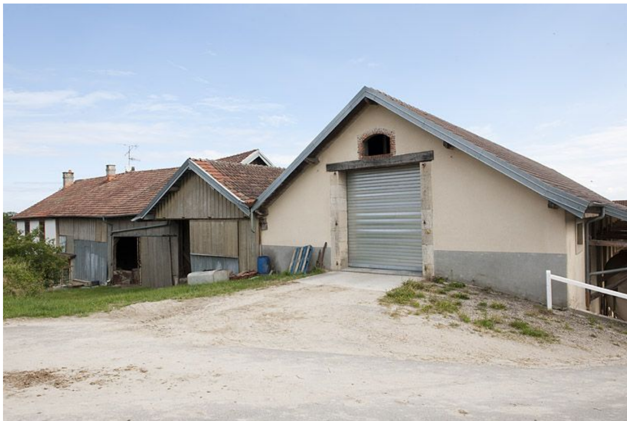
Pignons sud de l'écurie.
