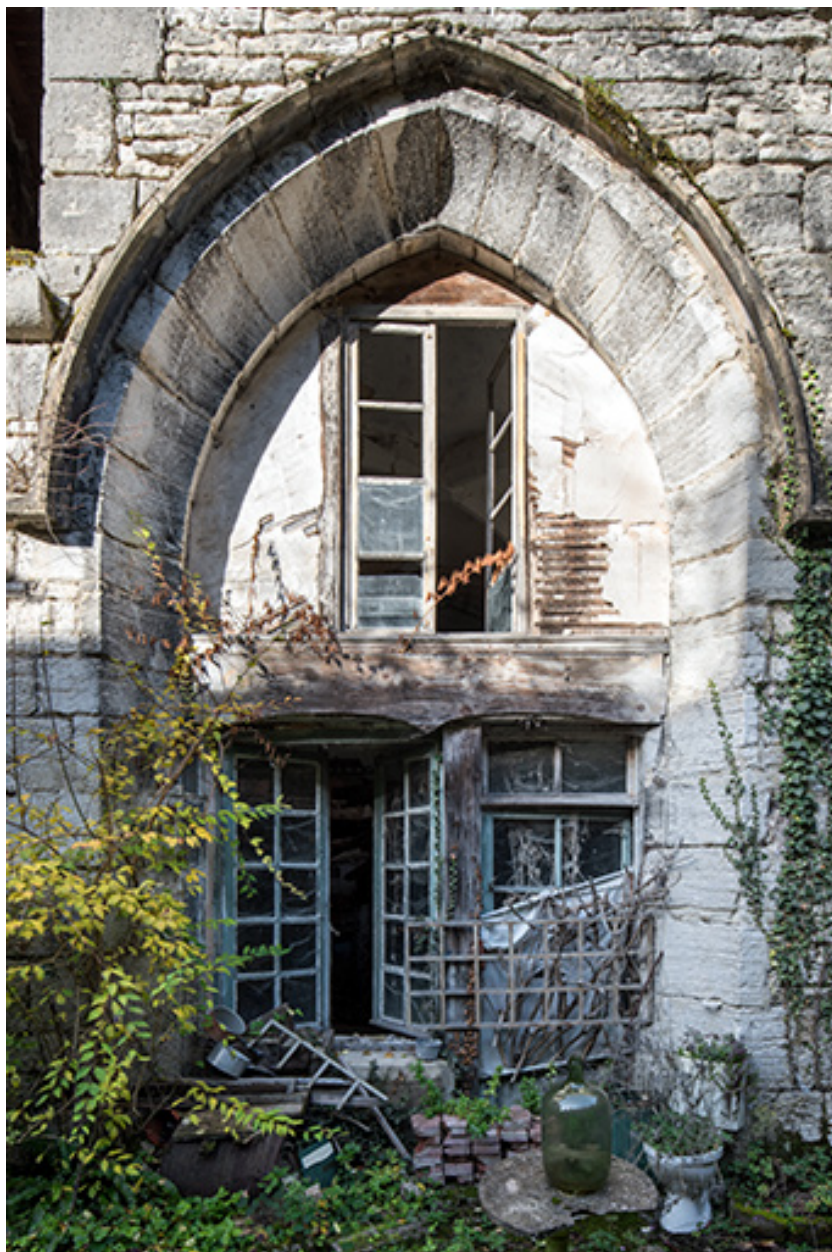
Fenêtre à arc brisé du chevet.
