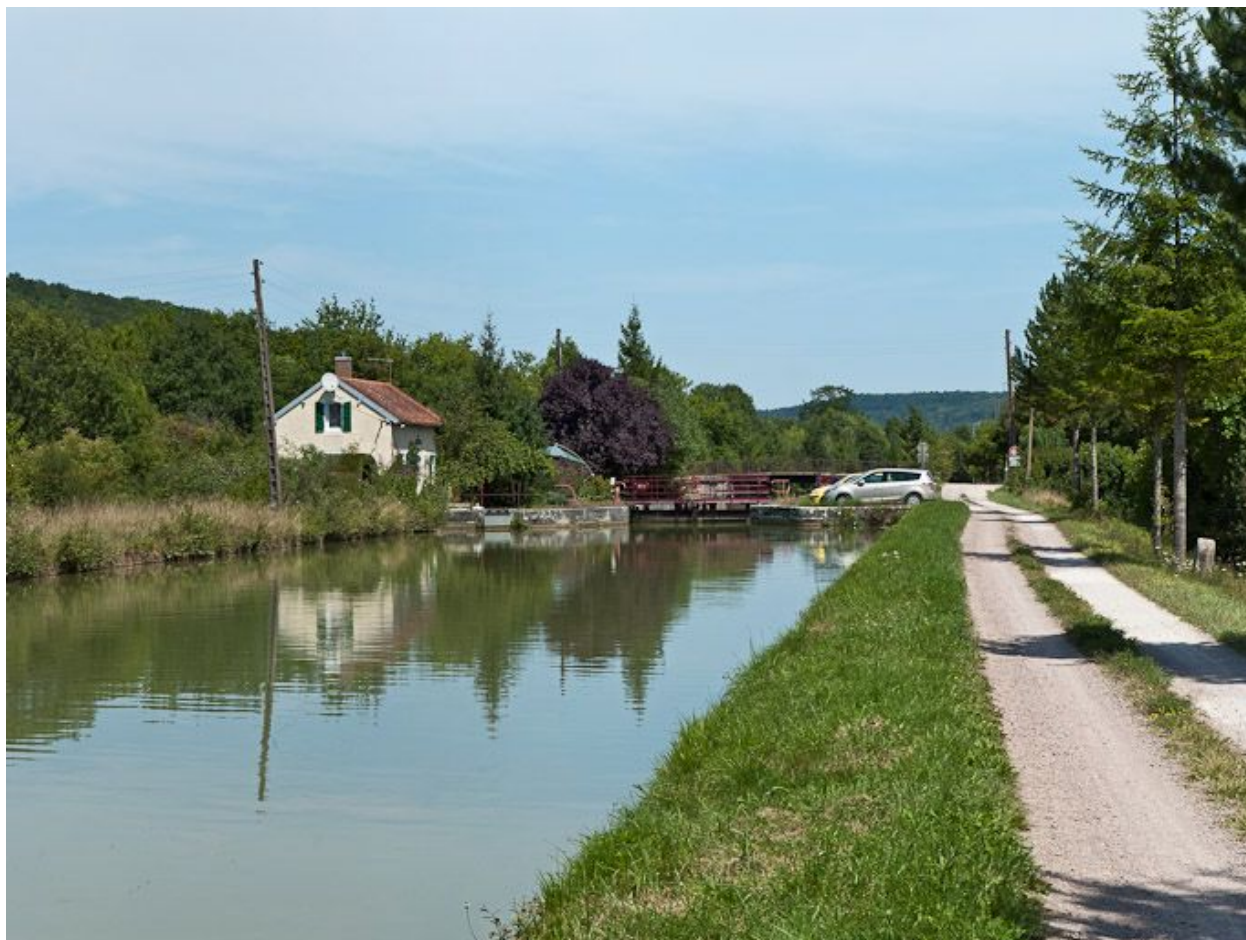
Vue du site d'écluse depuis l'amont
