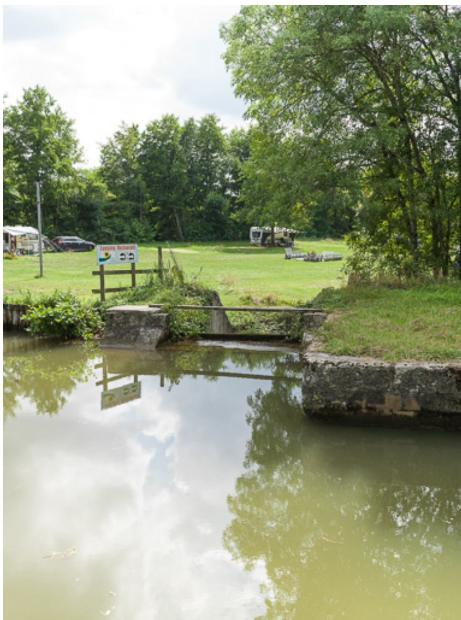
Vue du déversoir de superficie.
