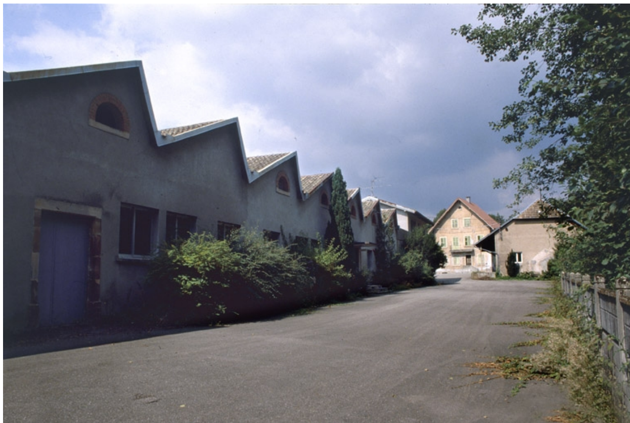
Sheds de l'atelier de filature.
