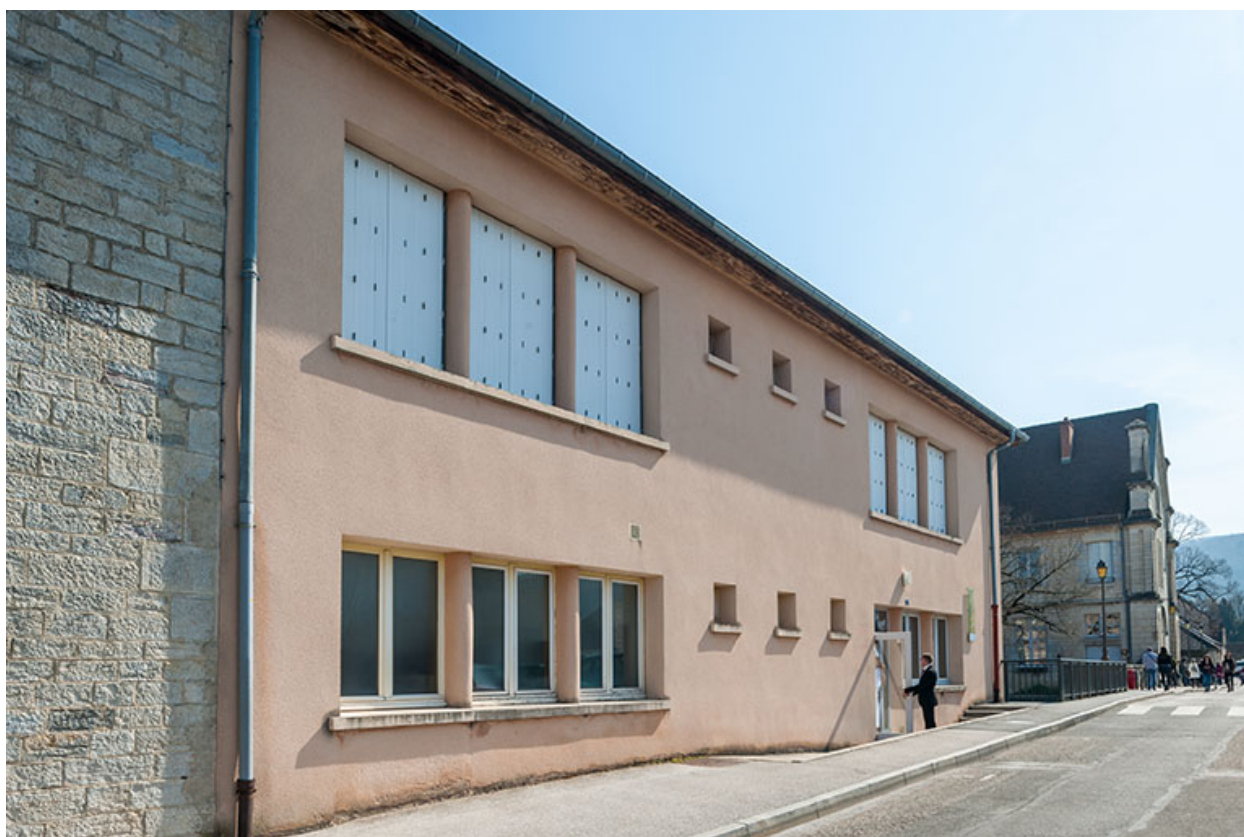
Annexe : façade antérieure, vue trois-quart.
