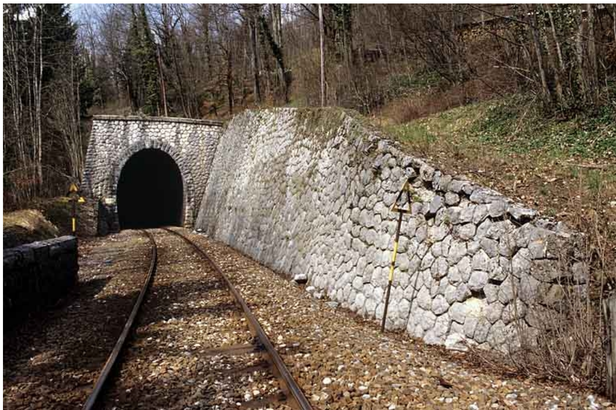
Vue d'ensemble de la tête côté Andelot-en-Montagne.
