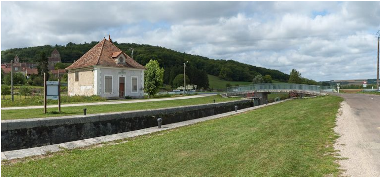
Vue d'ensemble du site d'écluse.
