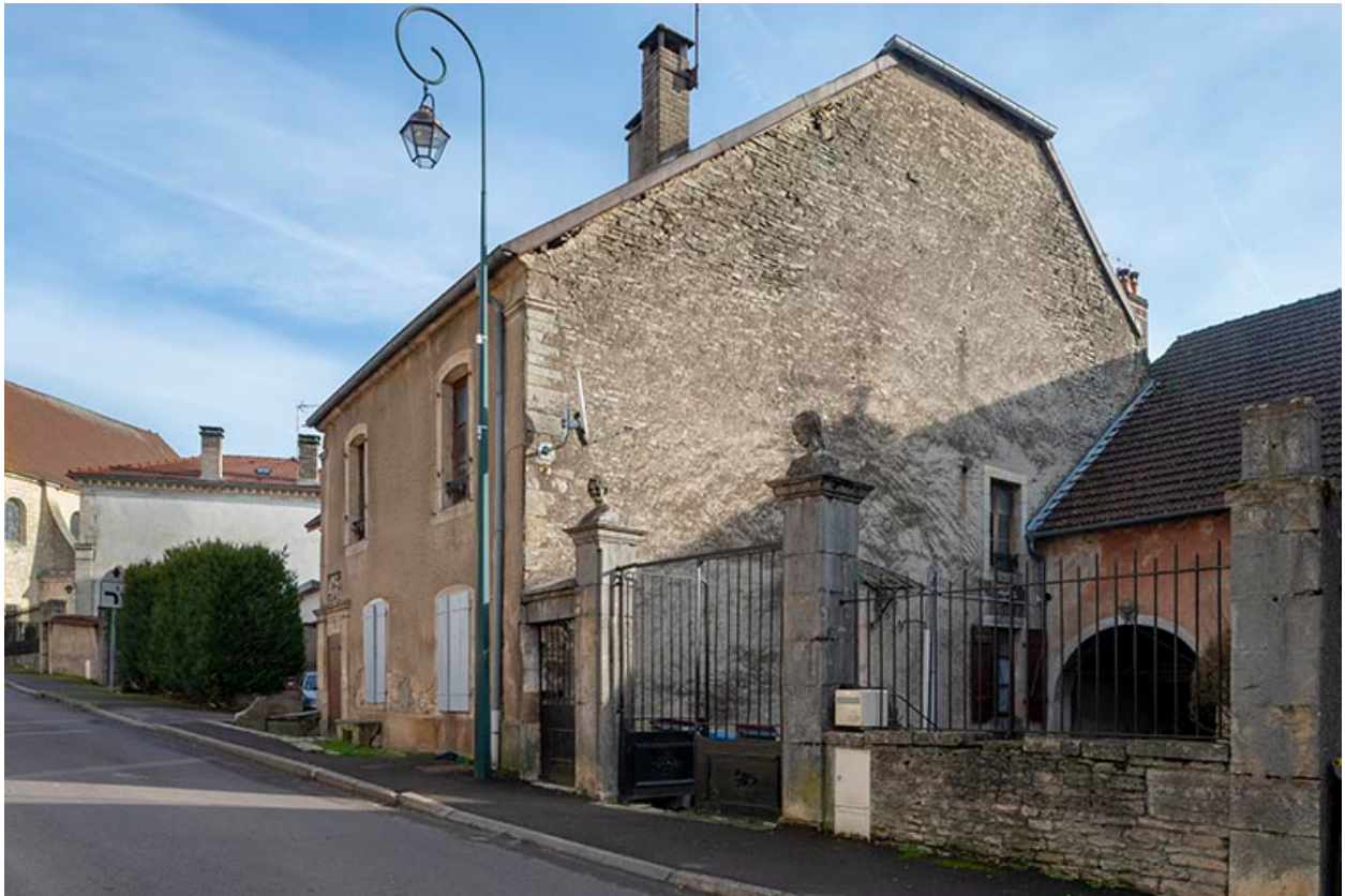
Vue de trois-quarts depuis le sud-ouest.
