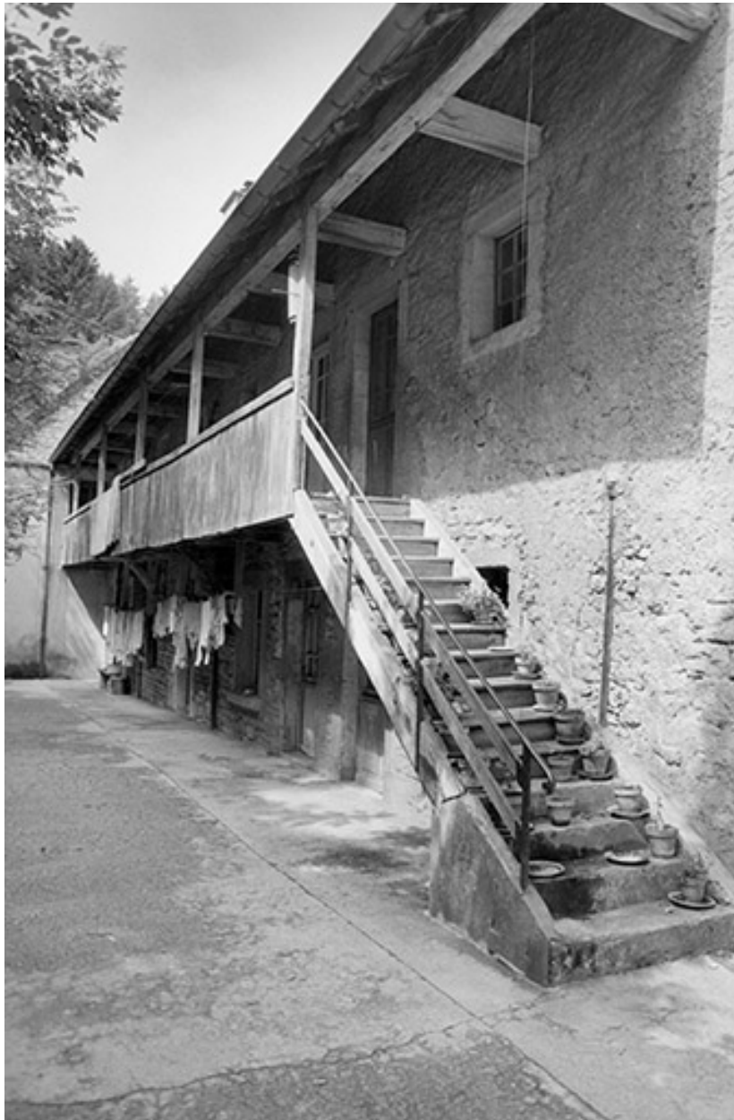
Façade postérieure d'un logement ouvrier en 1980.
