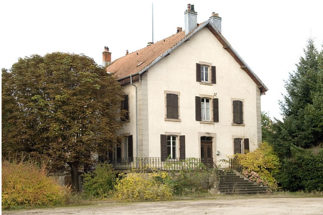
Logement patronal. Vue de trois quarts.
