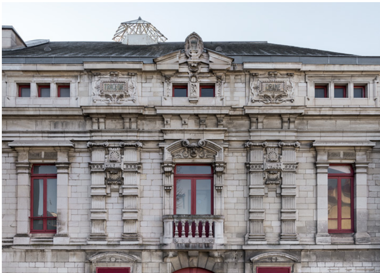
Façade latérale gauche : étage carré et attique.
