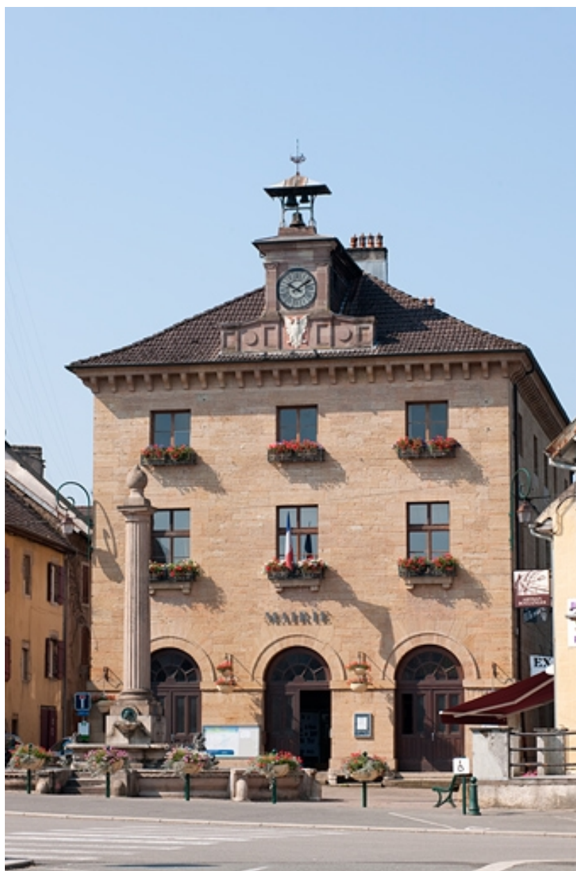
Façade antérieure de trois quart droit.
