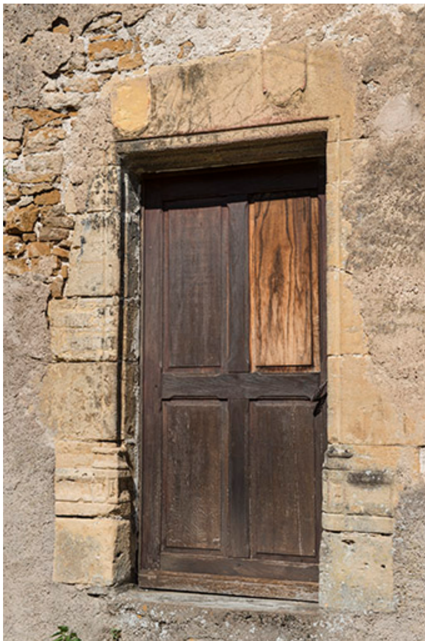
Porte latérale, façade sud.
