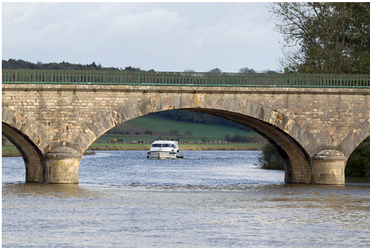
Détail d'une arche maçonnée du pont.
