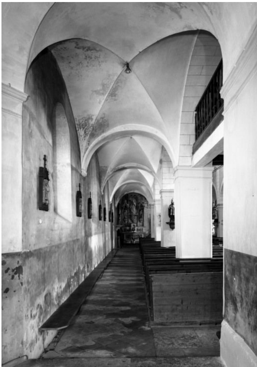
Bas-côté gauche, vue prise de l'entrée
