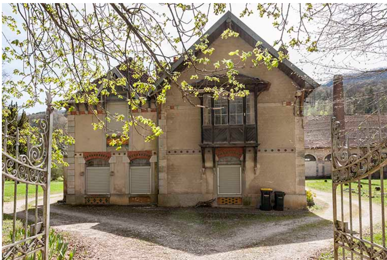
Pignon nord du logement patronal.
