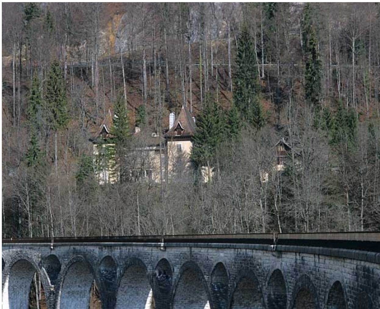
Vue d'ensemble rapprochée, depuis le sud-est.
