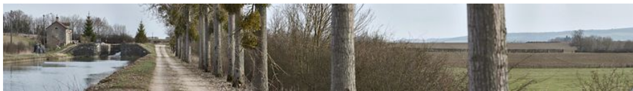
Le site d'écluse vu d'aval. Alignement d'arbres.
