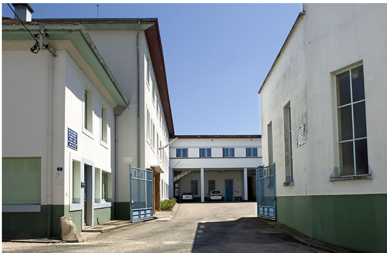
Entrée de l'usine.
