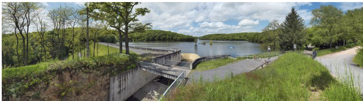
Vue d'ensemble du réservoir.
