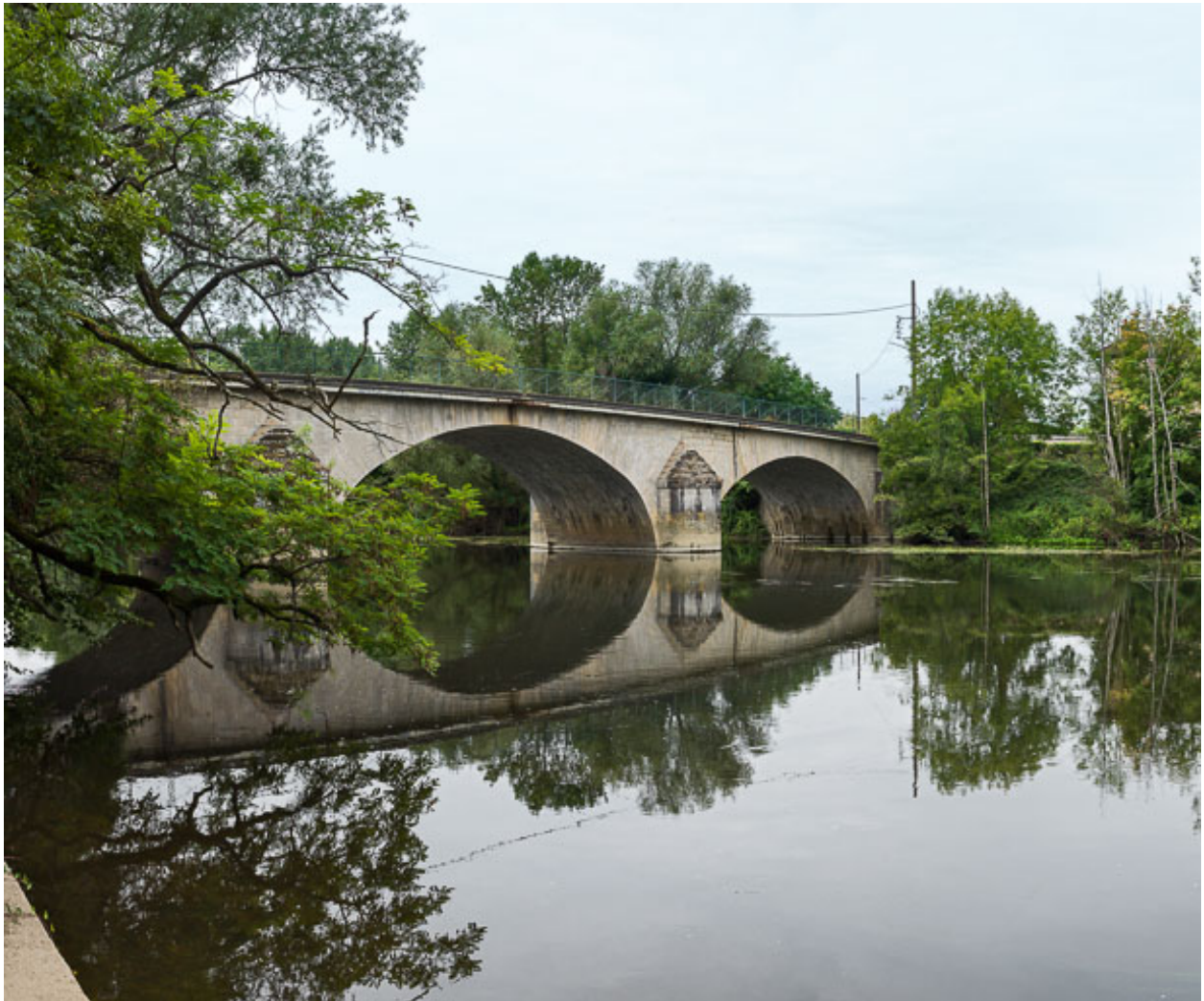
Vue d'ensemble du pont.
