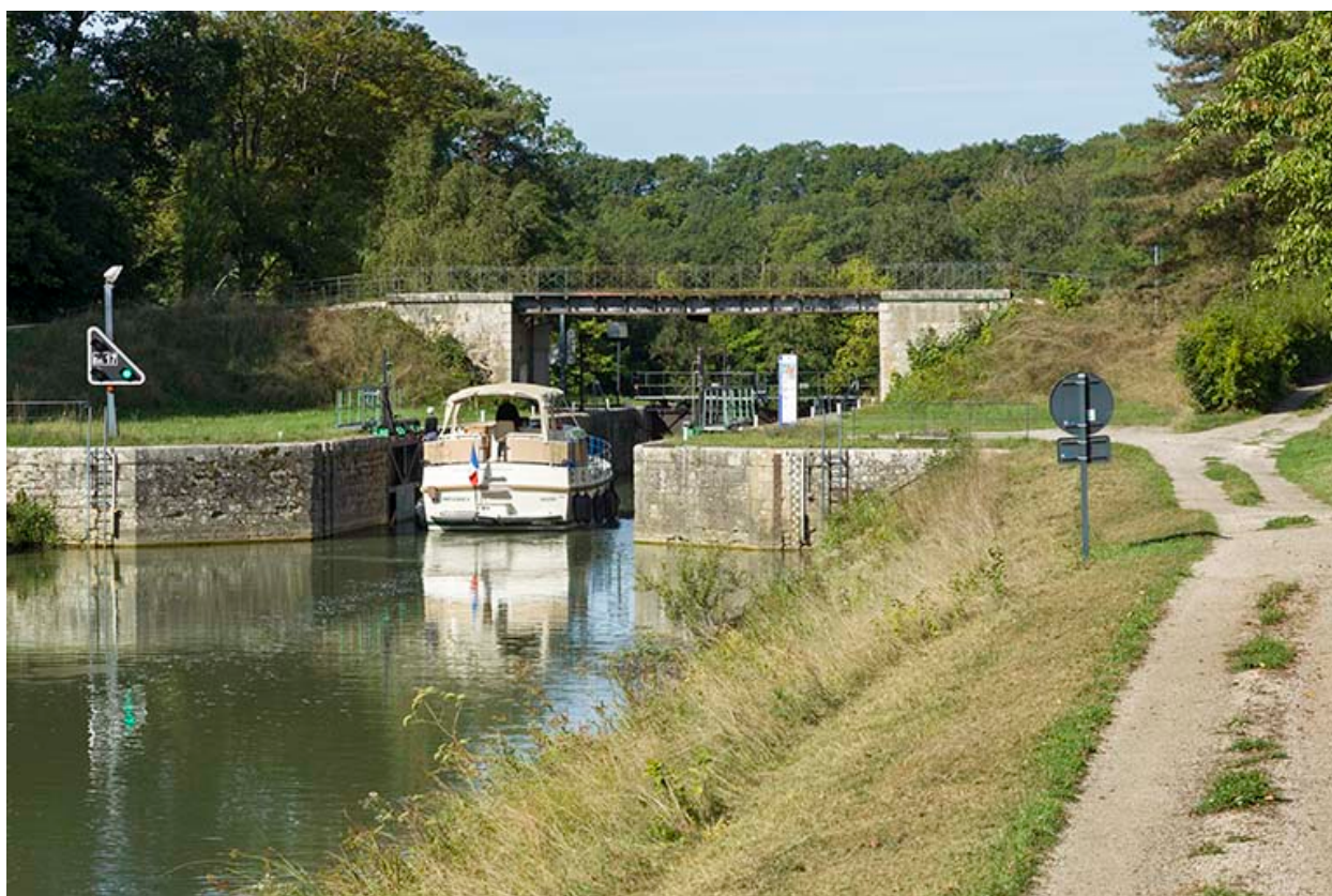
Bateau en amont de l'écluse à sas.
