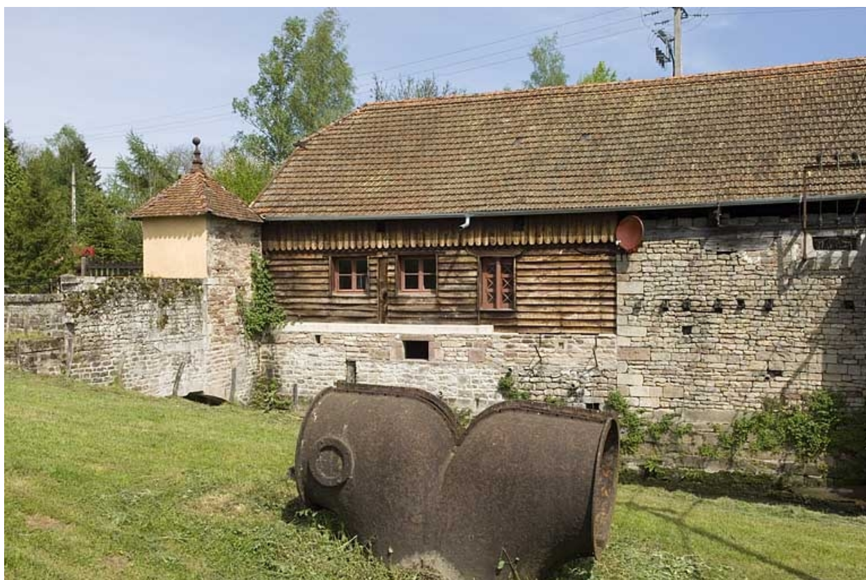
Façade sud de l'atelier de fabrication.
