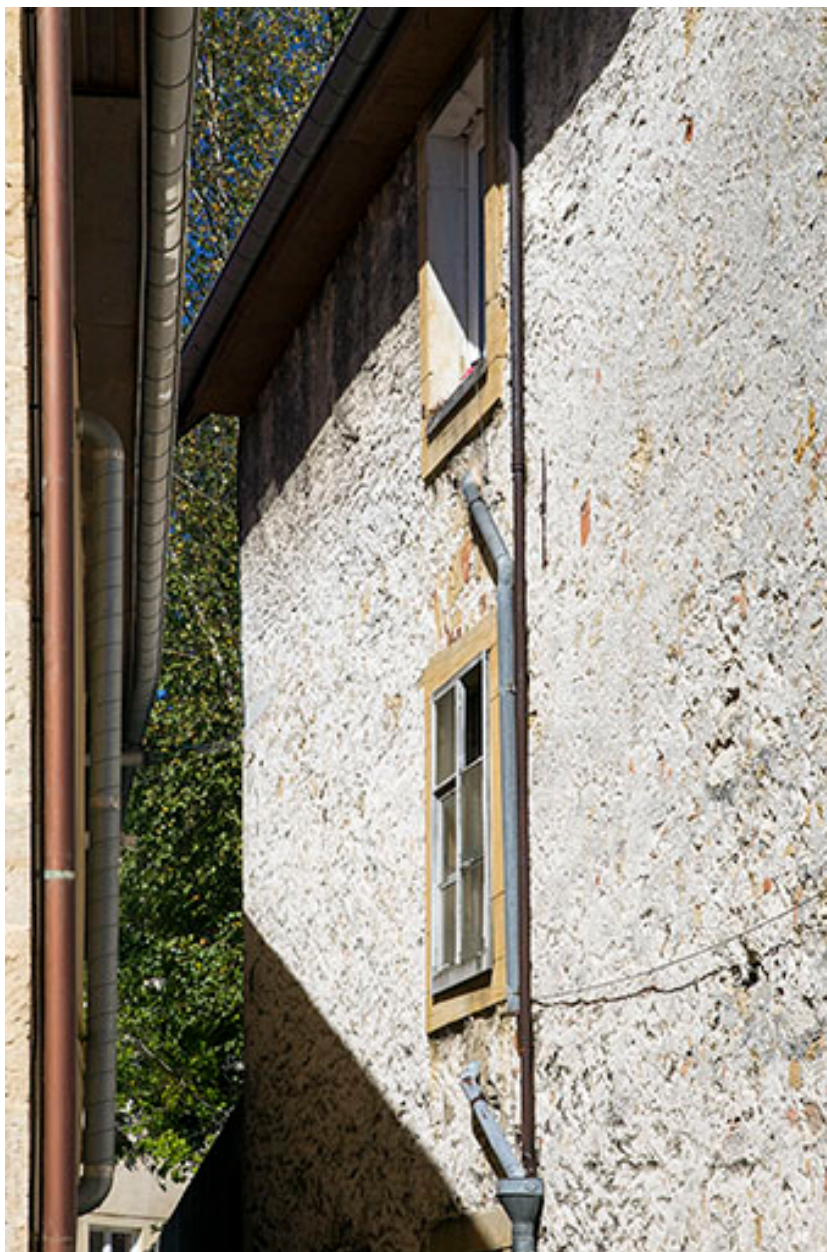
Baies sur le mur ouest.
