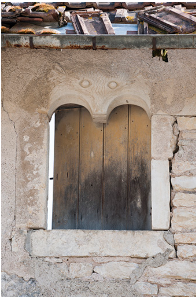
Détail d'une fenêtre du premier étage.
