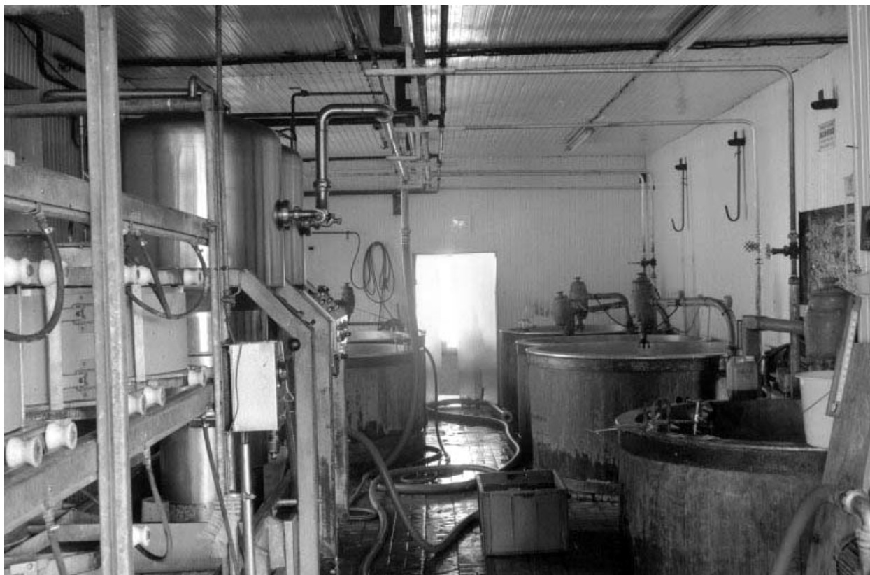
Intérieur de l'atelier de fabrication.
