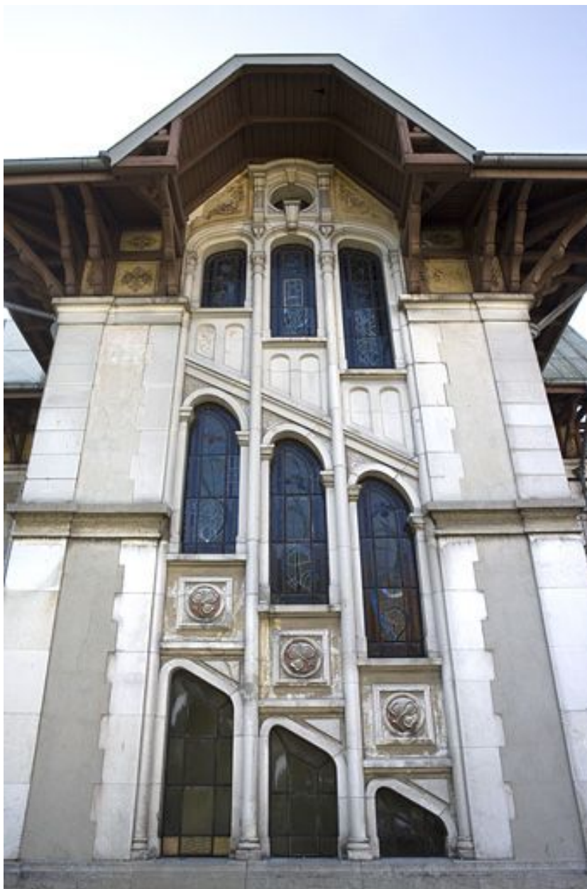
Elévation latérale gauche, en contre-plongée.
