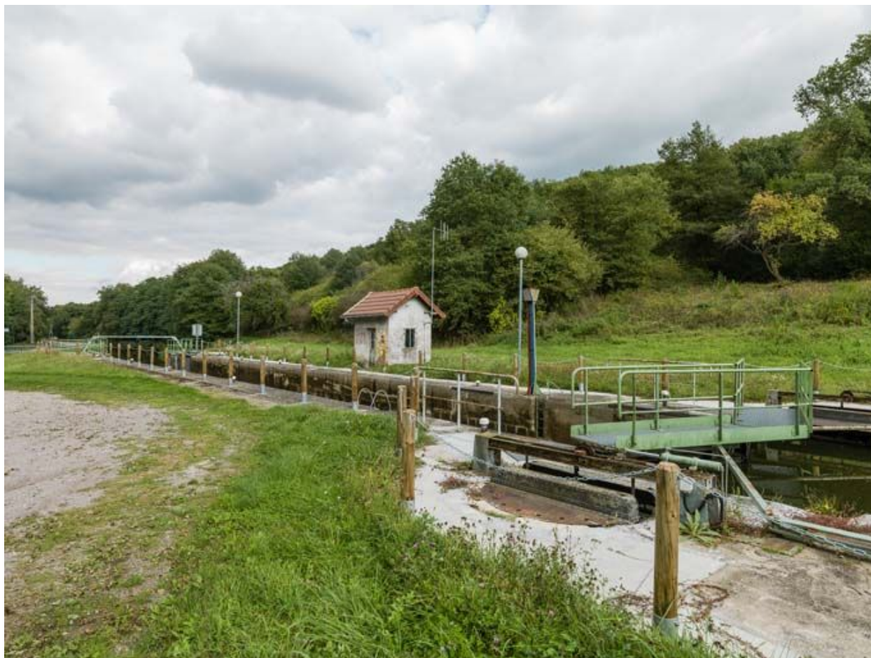
Vue d'ensemble du site d'écluse.
