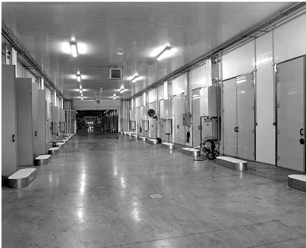
Couloir central des pièces d'affinage.
