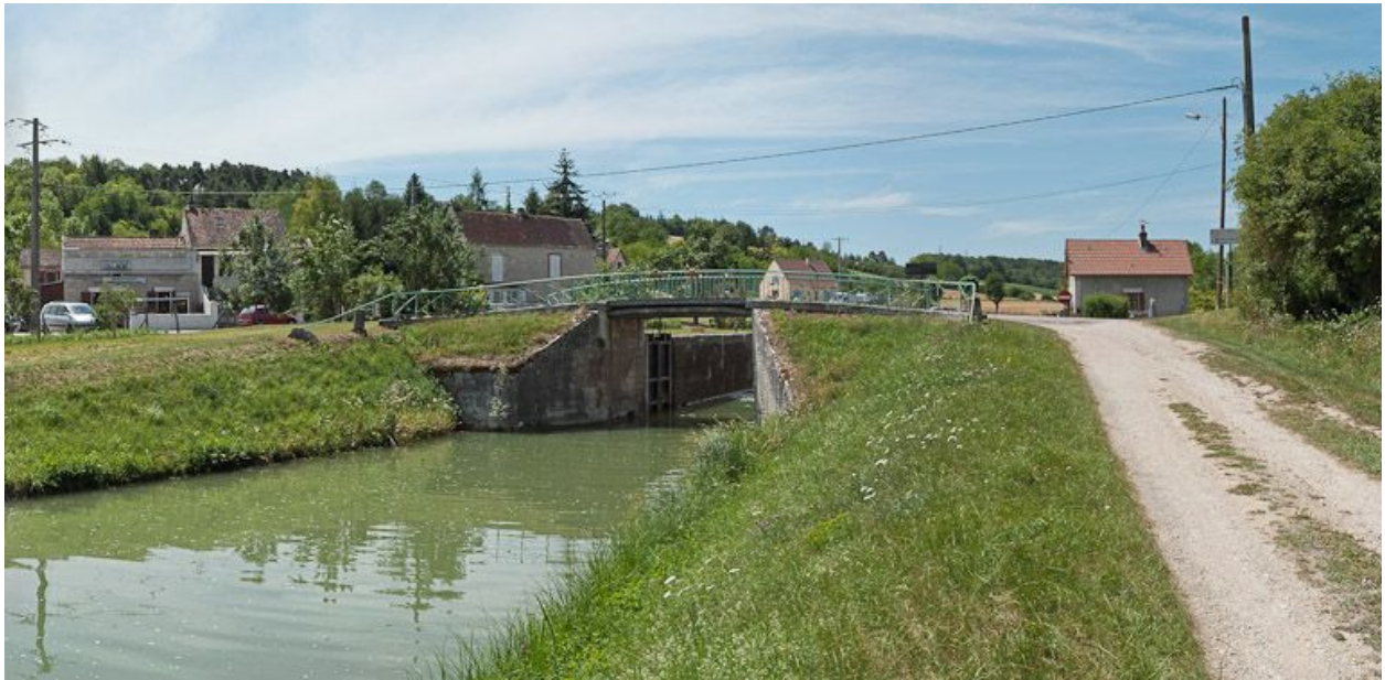
Vue du pont depuis l'aval.
