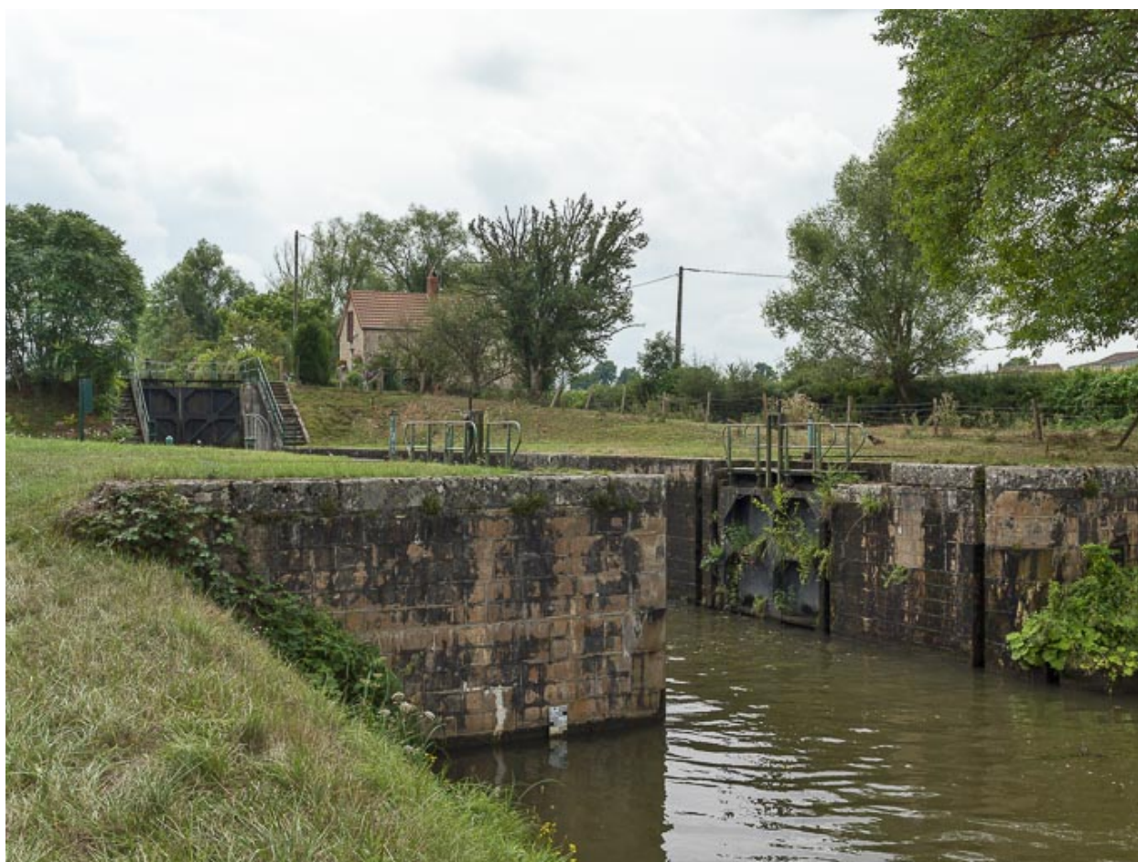
Le second sas, vu d'aval.
