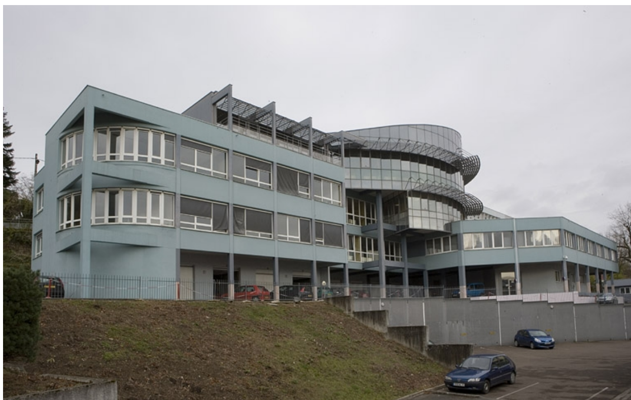
Vue d'ensemble bâtiment D depuis parking.
