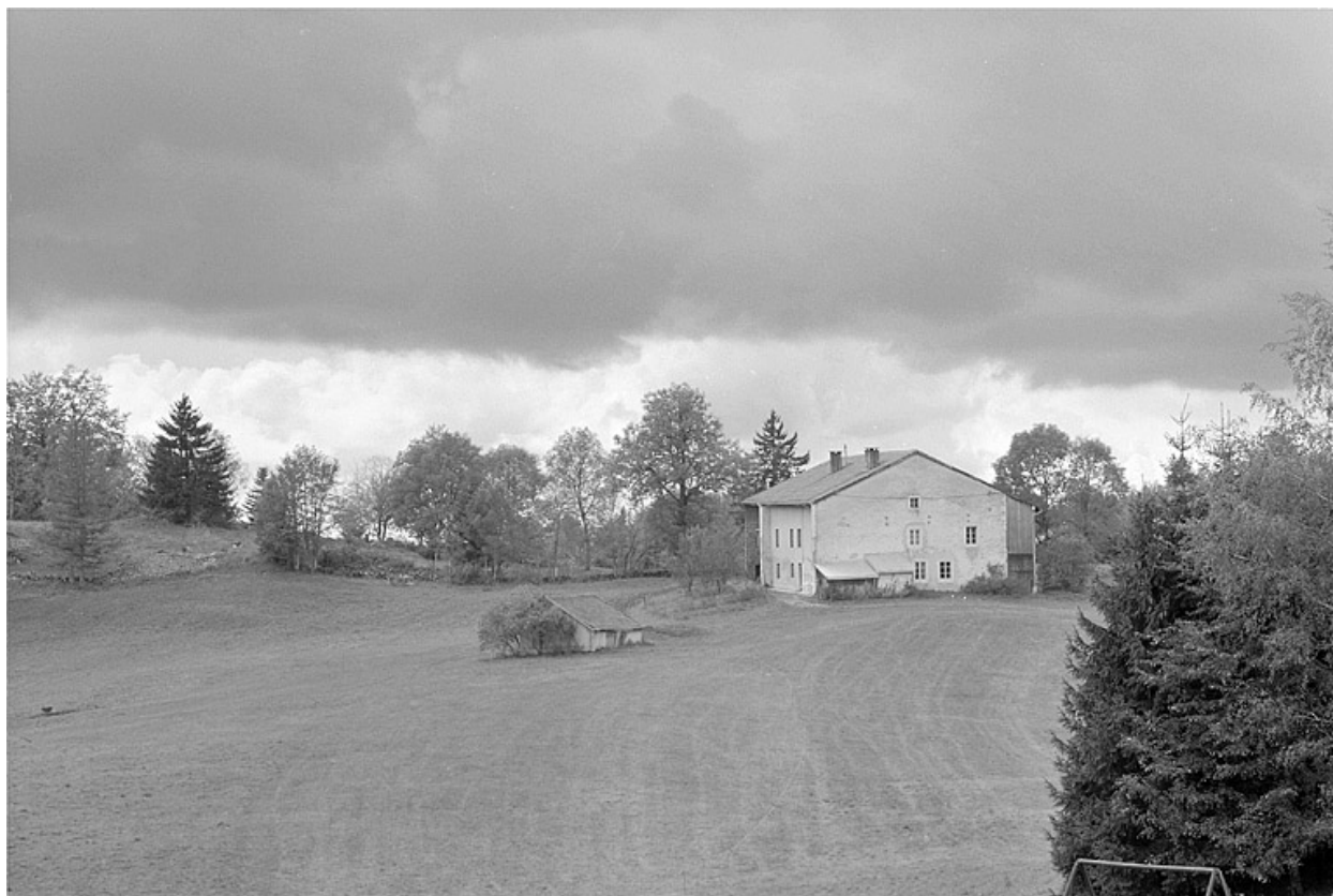
Vue générale depuis l'est.
