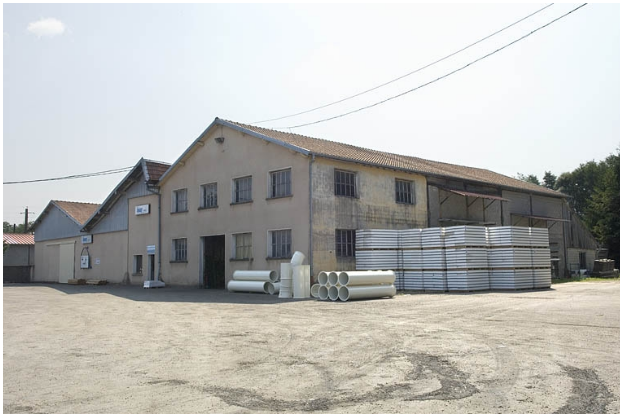
Magasin industriel (ancien four culée).
