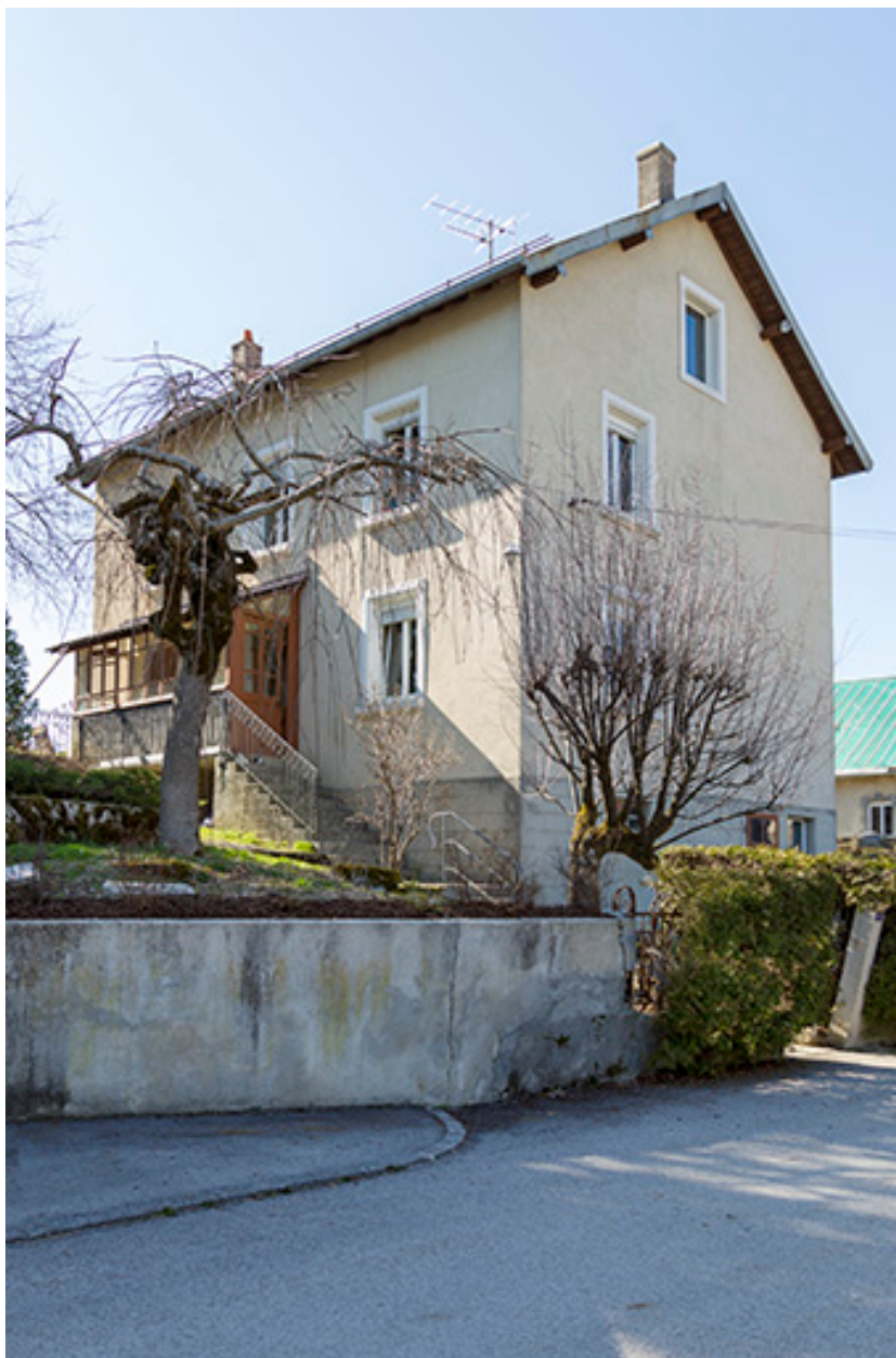
Façades antérieure et latérale droite.
