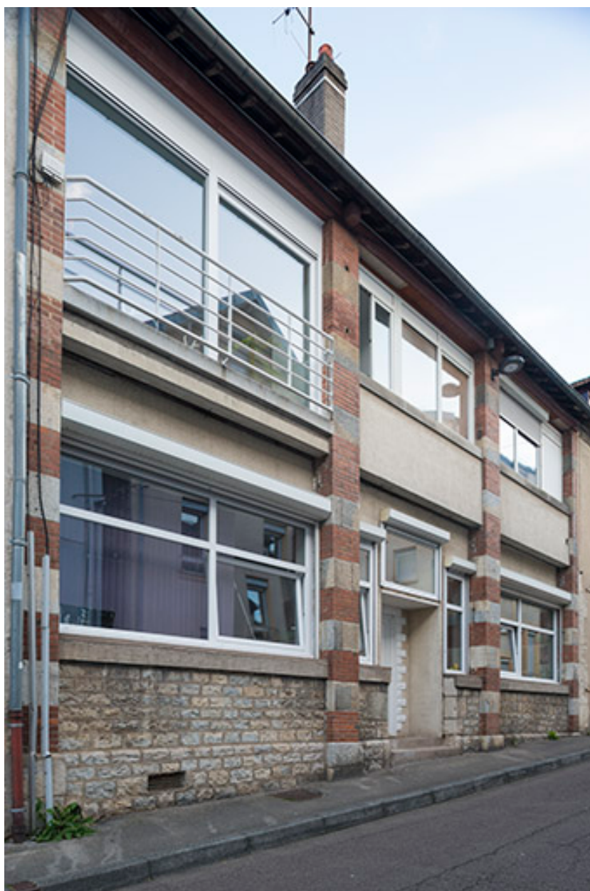
Façade antérieure vue de trois quarts gauche.
