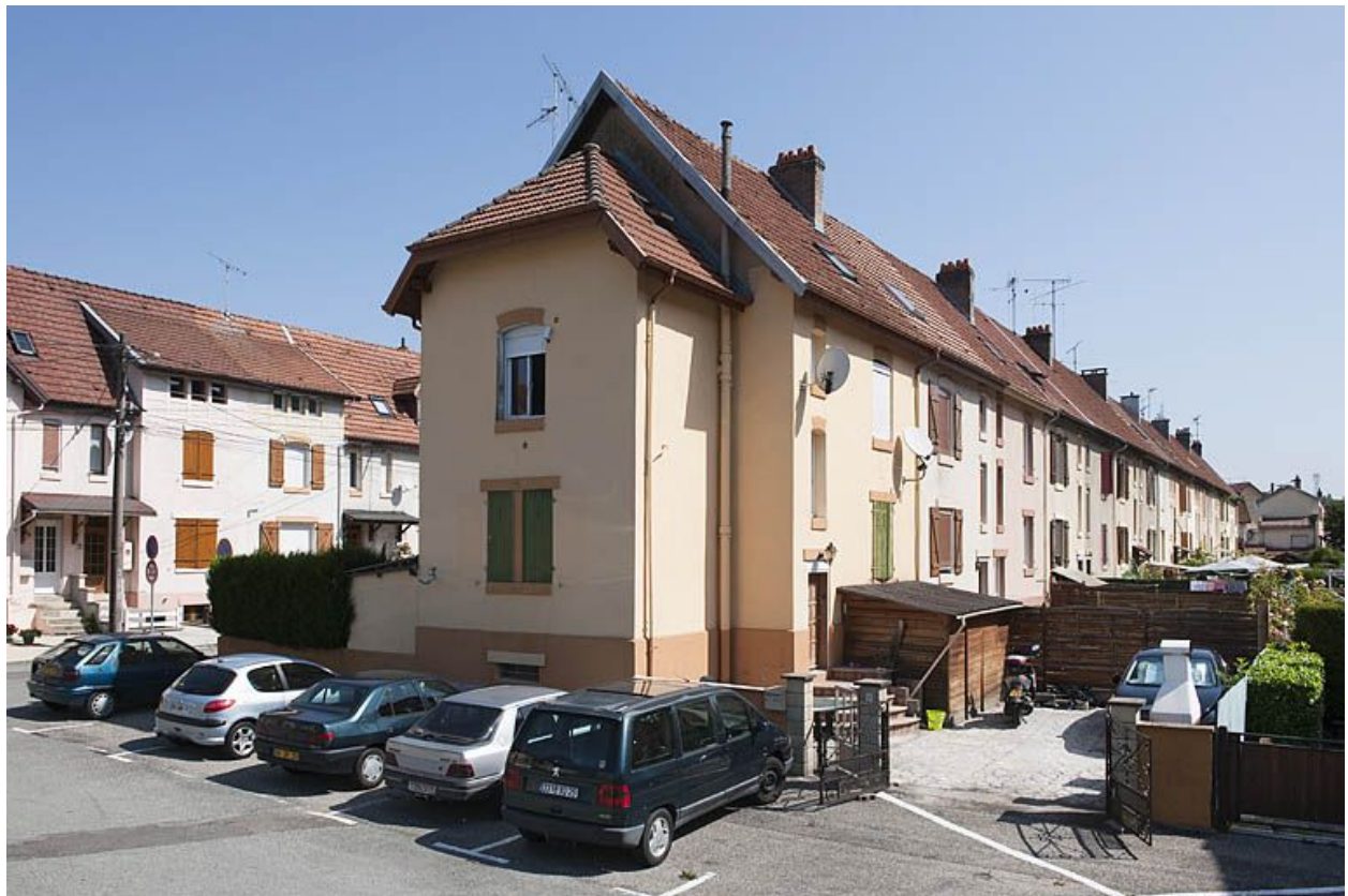
Immeuble rue de Flandres depuis le sud-ouest.
