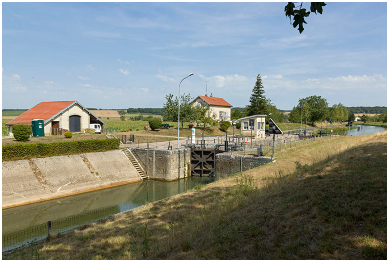
Vue générale du site d'écluse.
