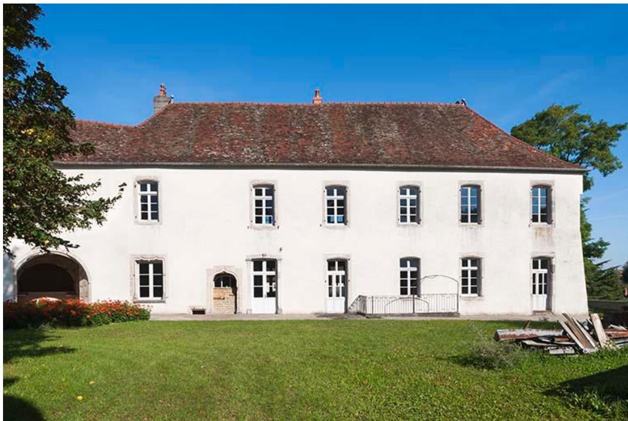
Vue générale sud
