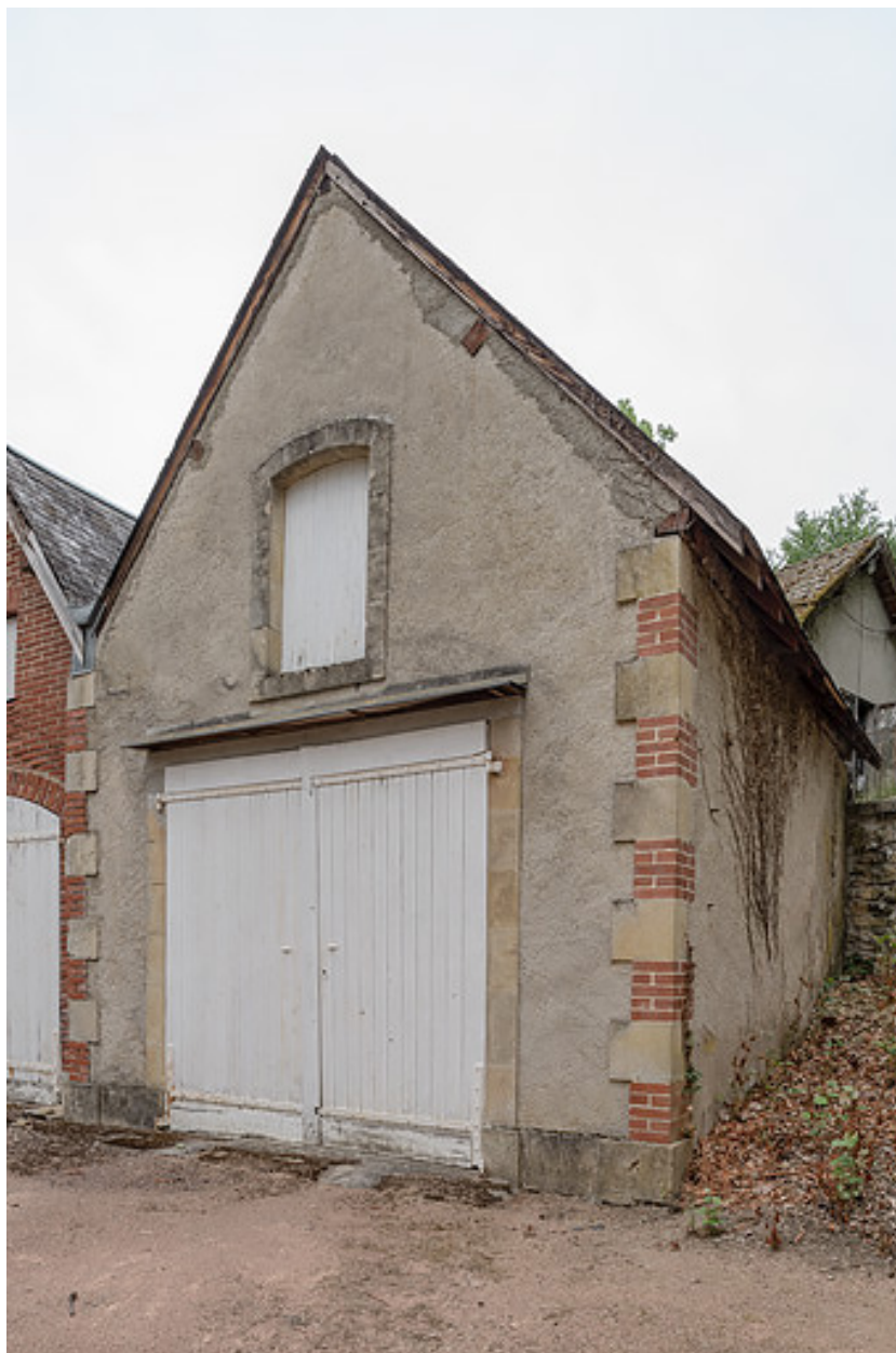
Mur-pignon du corps de droite.
