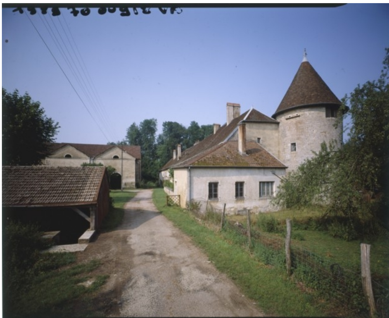
Vue d'ensemble depuis l'entrée en 1989.
