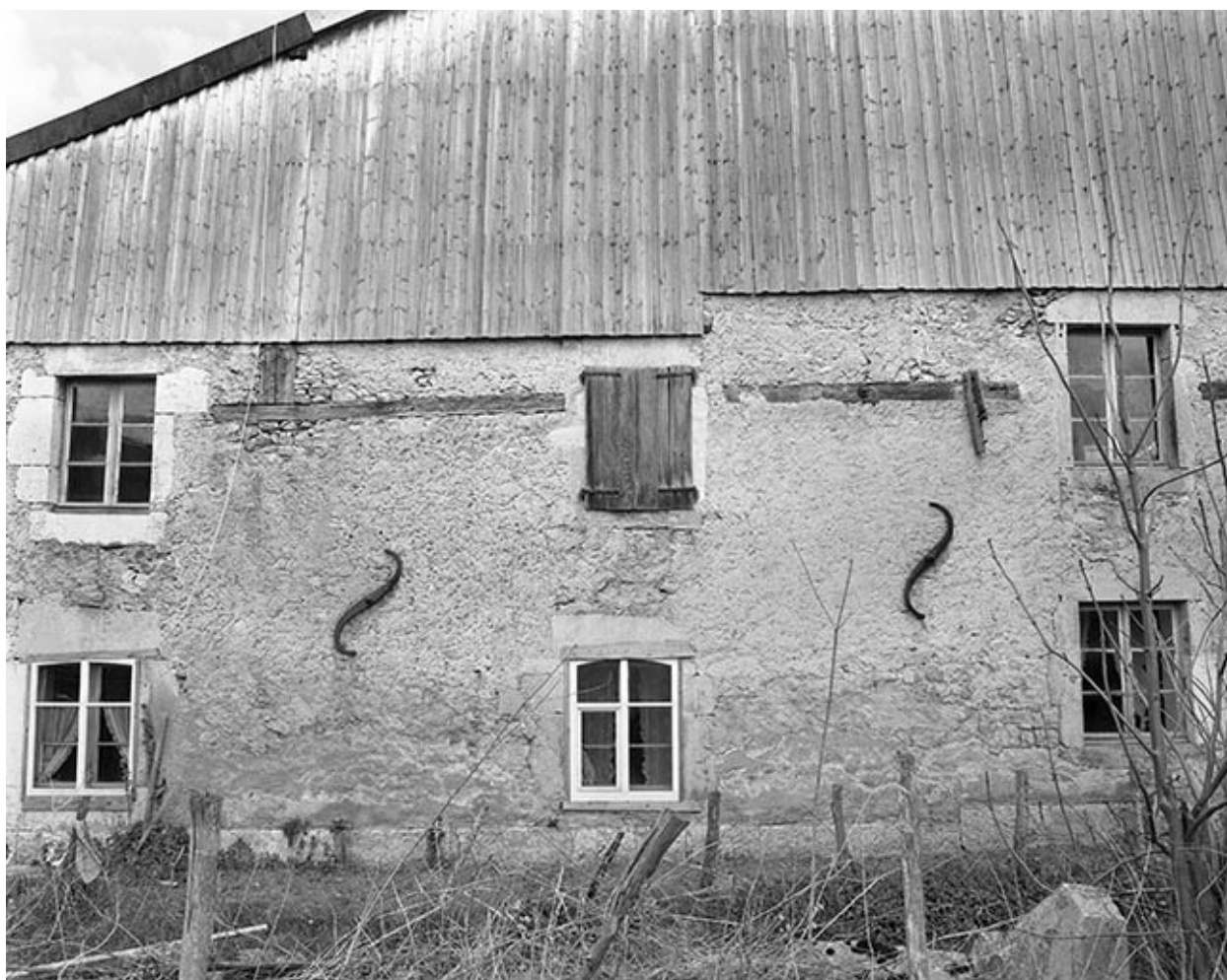
Détail du pignon d'habitation.
