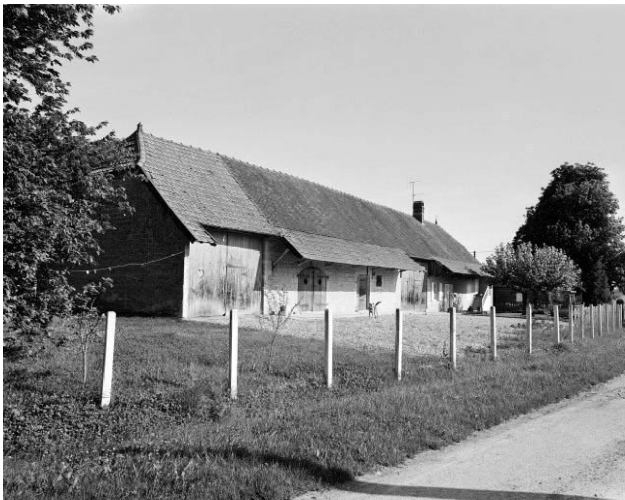
Ferme située rue de Jousseau : façade antérieure.
