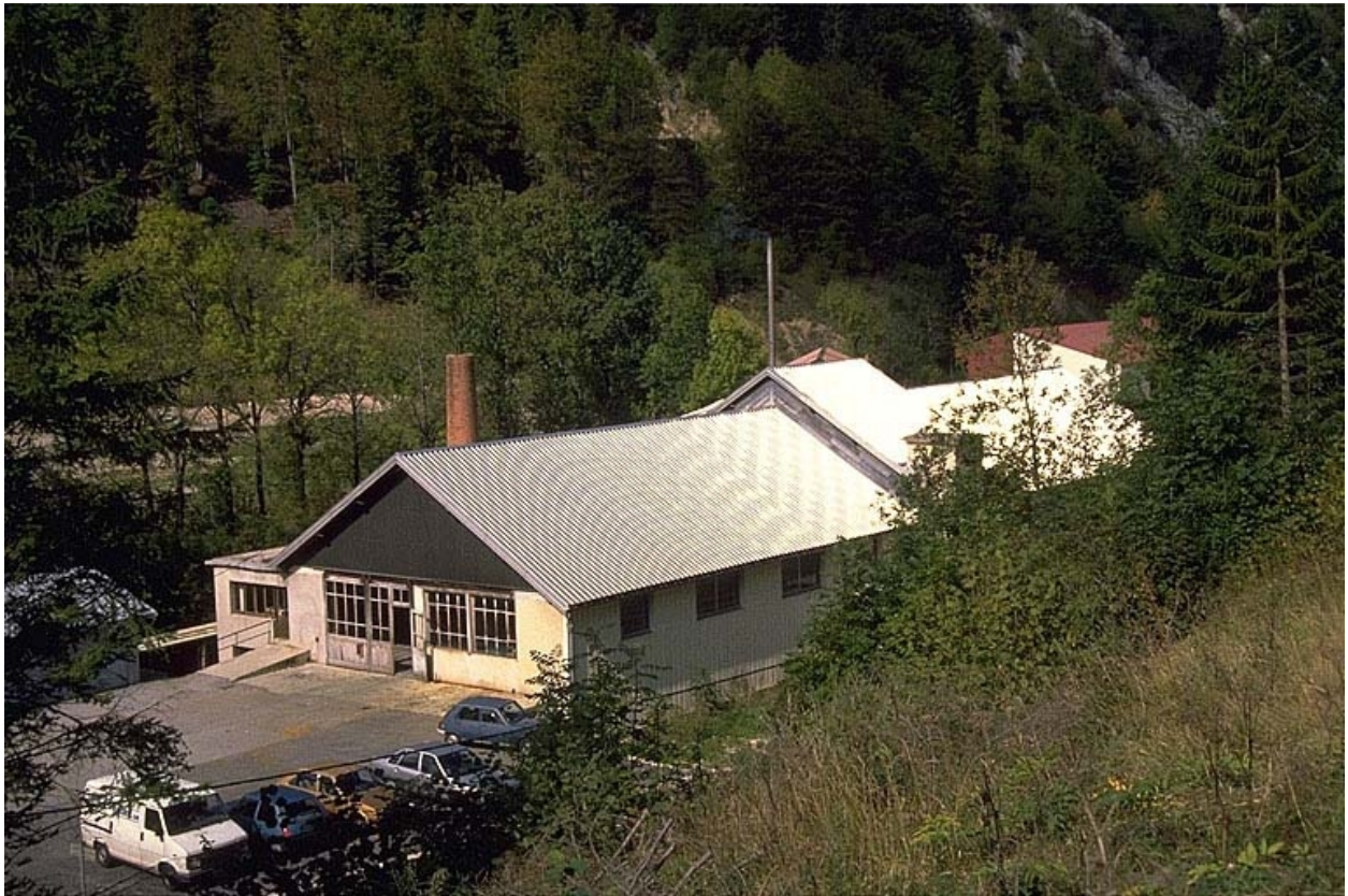
Vue plongeante sur la façade antérieure.
